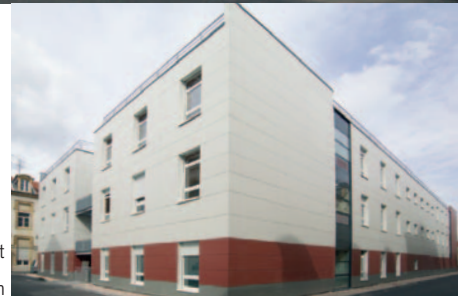
Großprojekt mit 118 Raummodulen
