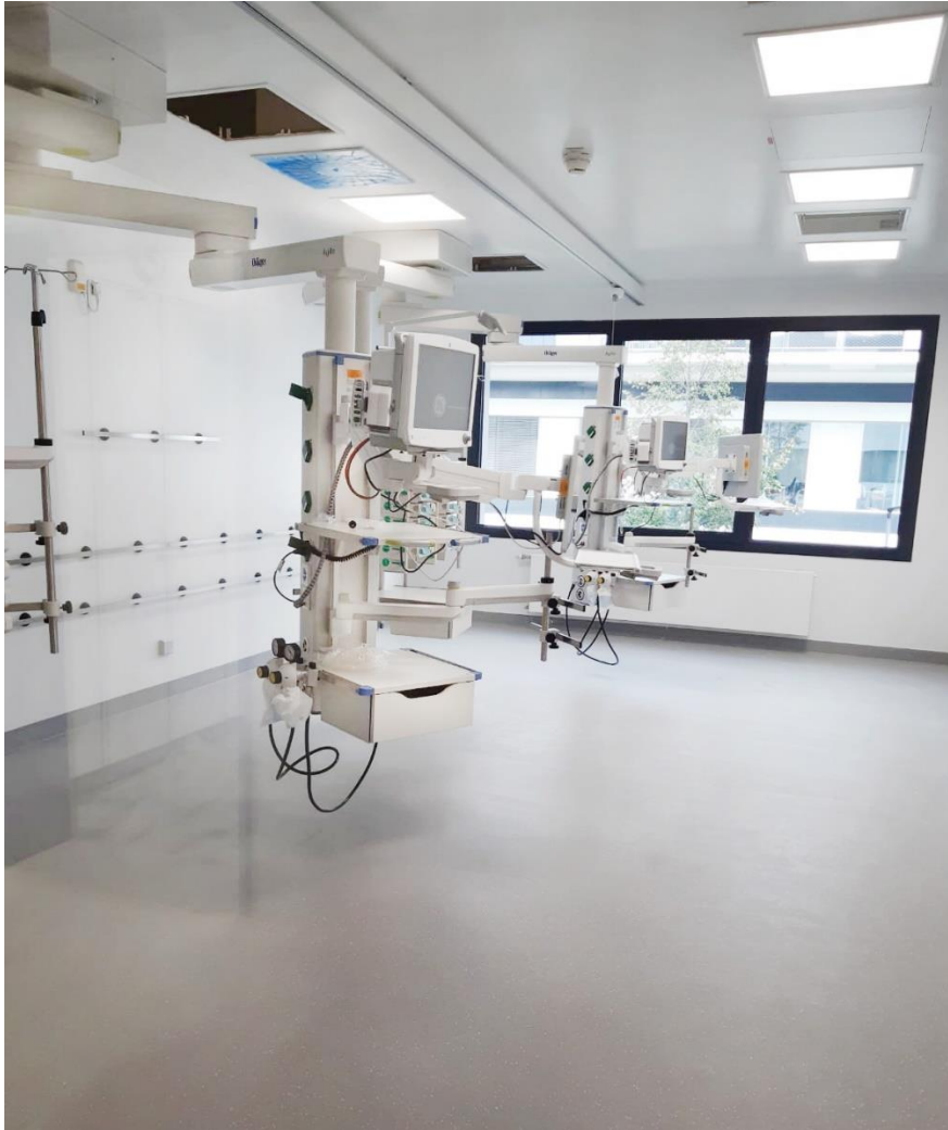
Foto: Dräger TGM GmbH, Cadolto Modulbau GmbH
