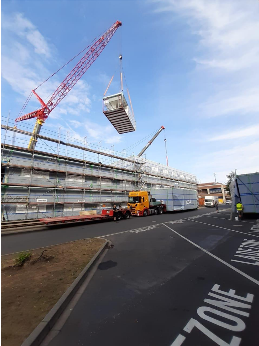
Foto: Modulaufstellung am Universitätsklinikum Düsseldorf, Cadolto Modulbau GmbH
