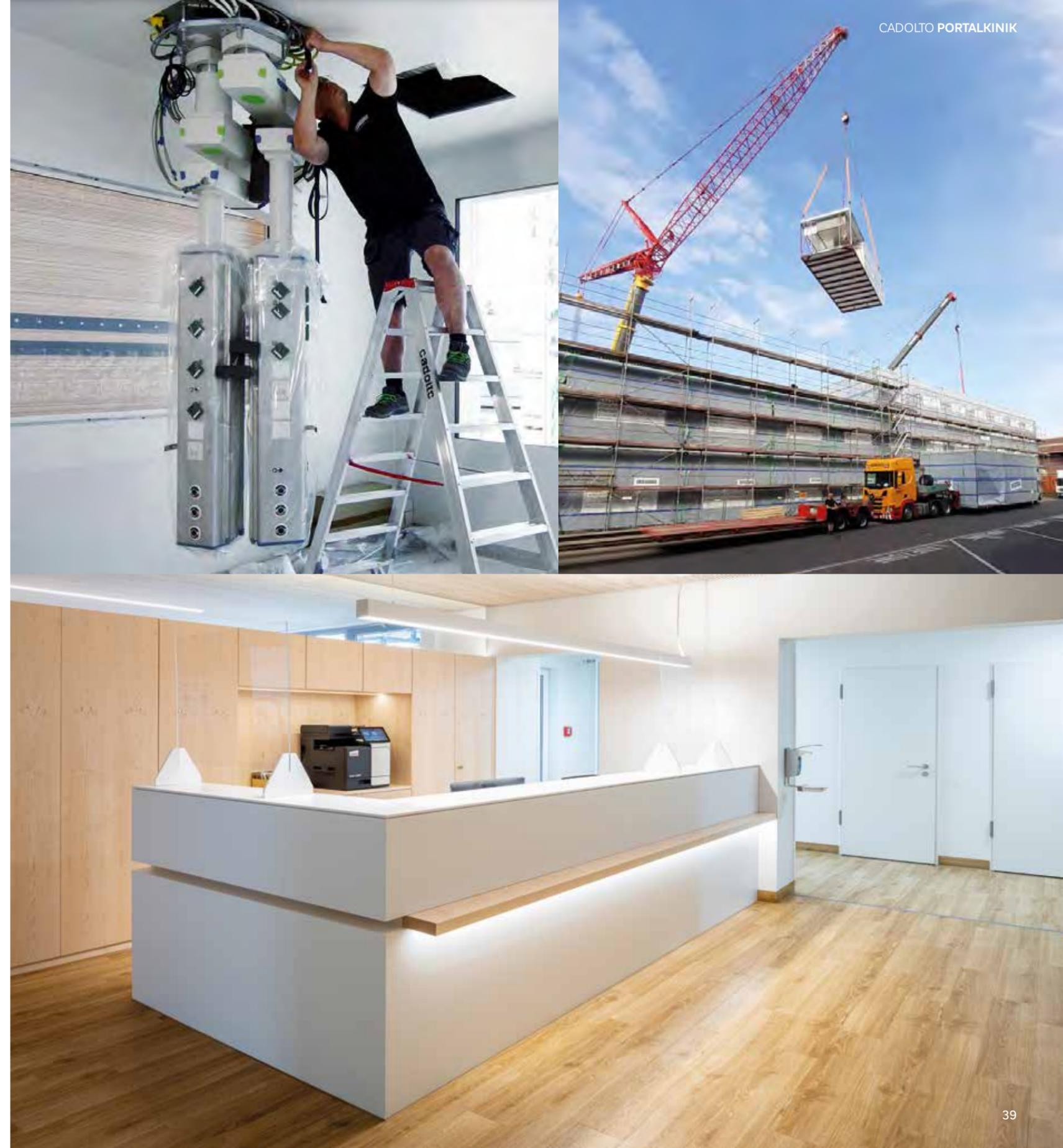
Die Module verlassen das Werk voll ausgestattet. Inklusiv der kompletten Medizin-, Labor- und Gebäudetechnik sowie Bädern, Beleuchtung, fest eingebauten Möbeln etc. Die Bauherren bleiben flexibel: An-, Um- und Rückbau, der Umzug ganzer Gebäude – alles ist möglich. Und das mit großer Nachhaltigkeit: kaum Emissionen auf der Baustelle, deutlich weniger LKW-Verkehr, Wiederverwendbarkeit und recyclingfähige Materialien.
